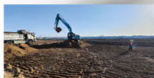
NIVELACIÓN DEL TERRENO
