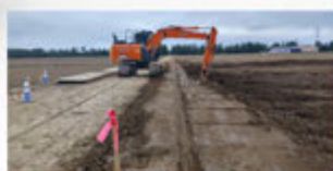
CONSTRUCCIÓN DE CARRETERAS
