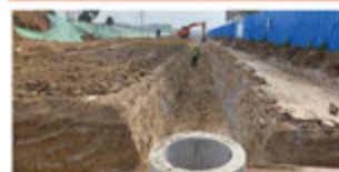
EXCAVACIÓN EN ZANJAS
