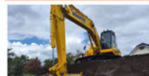
CONSTRUCCIÓN DE TALUDES Y EMBALSES
